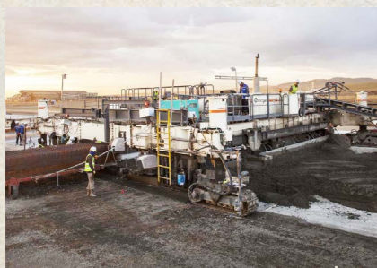
一度に2レーンの同時施工が可能な大型フィニッシャーによる滑走路舗装の様子。
