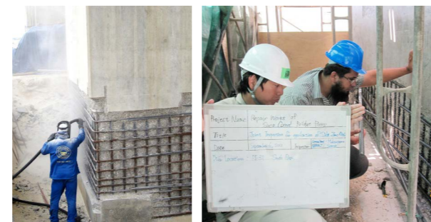
橋脚の鉄筋さびを除去している様子 日本企業が実施した工事の検査を行うエジプト人技術者
