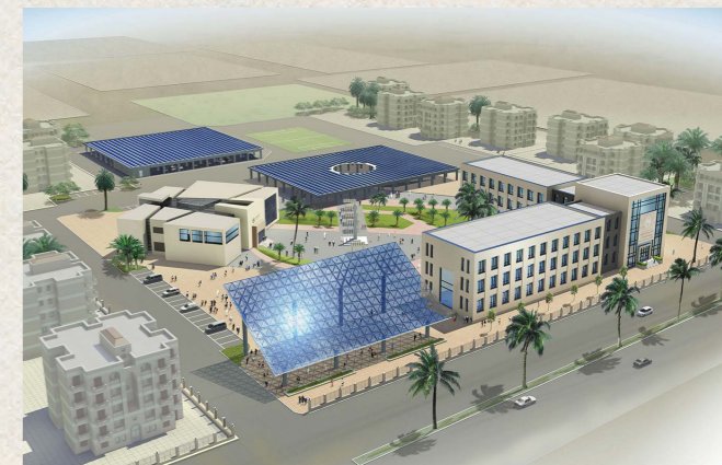
太陽光パネルは3箇所、架橋体の上に設置され、それぞれの下部は、アトリウム・広場・駐車場となっている。
