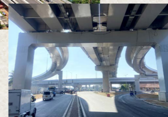
上:ジャンクション全景 下:ジャンクションの鋼桁と鋼製橋脚
