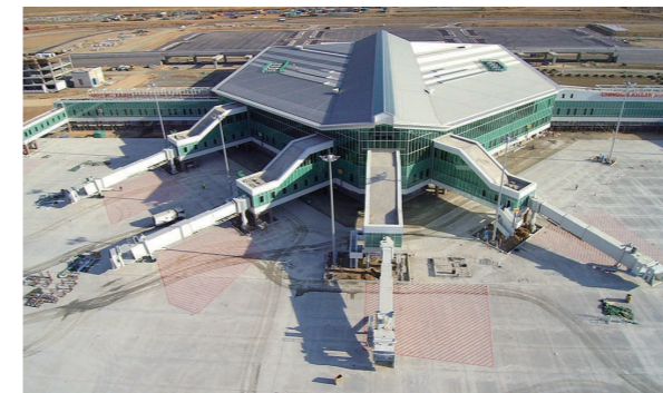
新ウランバートル国際空港 旅客ターミナルビル
