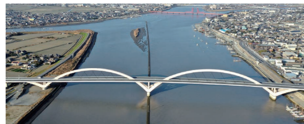
中央のデ・レイケ導流堤に橋脚を設置し筑後川を横断する有明後川大橋
