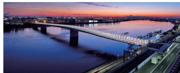
中央支間長が240メートルと国内最大級を誇る多摩川スカイブリッジ
