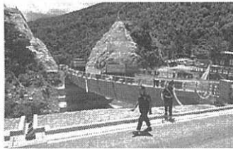
開通したチュゾムサ橋
