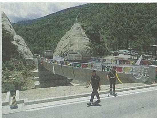
開通したチュゾムサ橋
