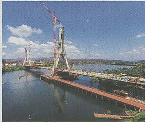
建設中のナイル架橋
