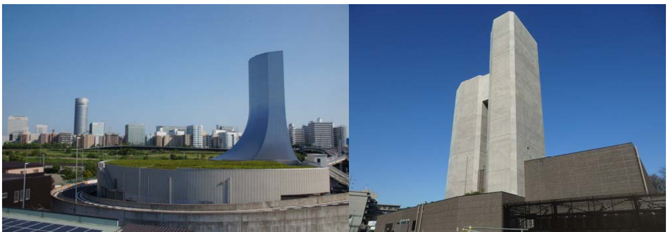
新横浜換気塔、馬場換気塔
